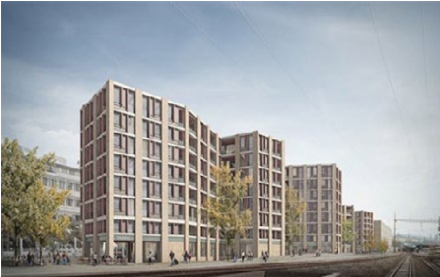
Das Pendant zur Europaallee: Neubauten an der Zollstrasse
