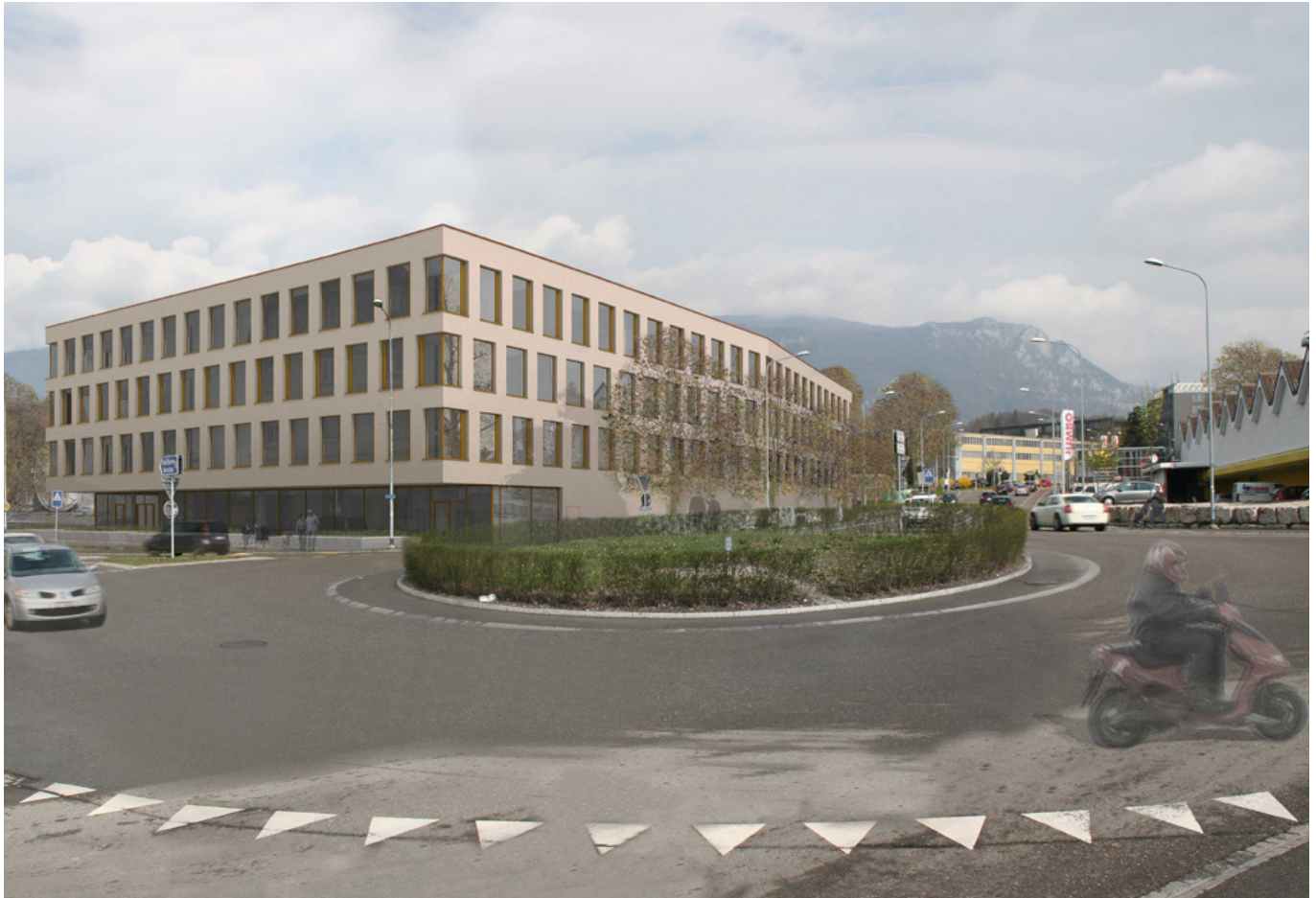
Sasolim-Projekt in Solothurn: Ein neues Büro- und Geschäftsbaus am Jumbo-Kreisel
