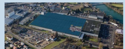
Areal Riverside Zuchwil: Derzeit leistungsstärkste Dach- Photovoltaikanlage der Schweiz.
