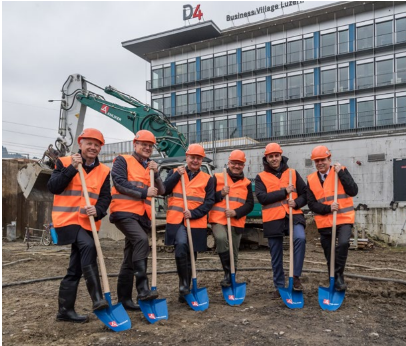
Der Spatenstich für die vierte Bauetappe des D4
